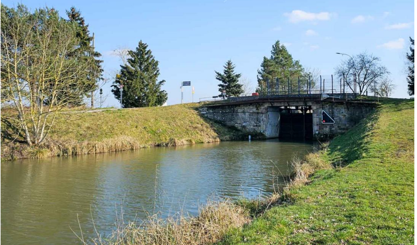
Écluse sur le canal de l'Est Branche Sud
